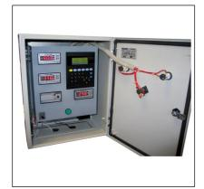
Комплект автоматики для подогревателей нефти и газа **ЩУП** служит для автоматизации работы подогревателей газа. Состоит из металлического шкафа с подогревом, контроллера, приборов контроля давления газа, разрежения и наличия пламени.
