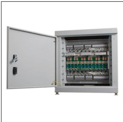
Вводно-защитное устройство **ВЗУ-СДПС** служит для защиты аппаратуры связи от грозовых и коммутационных перенапряжений.
